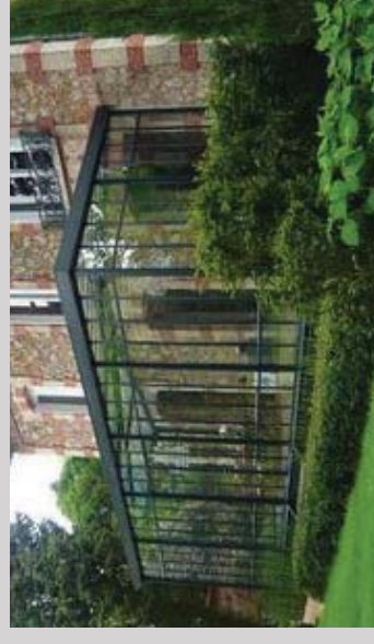
Véranda en acier sur façade en meulière
