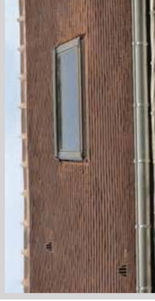
Châssis de toiture intégré à la couverture sans saillie
