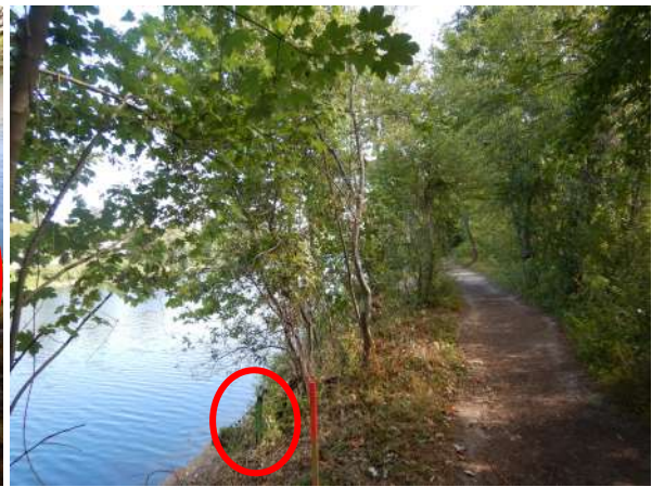
Piquetage rouge en sommet de digue le long du chemin matérialise et délimite chaque plot de 11 m de large, les autres piquets métalliques supportent les cellules nécessaires au théodolite.
