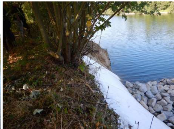
La limite d'engrochement marquée de piquets rouges (Cf. compte rendu de réunion du 11 mai 2023) est respectée, les zones les plus abruptes et les plus dépourvues de végétaux d'avenir sont terrassées plus fortement pour consolidation et confortement de la digue. Ceci est conforme au marché et au projet.
