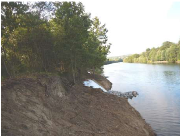
La limite d'engrochement marquée de piquets rouges (Cf. compte rendu de réunion du 11 mai 2023) est respectée, les zones les plus abruptes et les plus dépourvues de végétaux d'avenir sont terrassées plus fortement pour consolidation et confortement de la digue. Ceci est conforme au marché et au projet.
