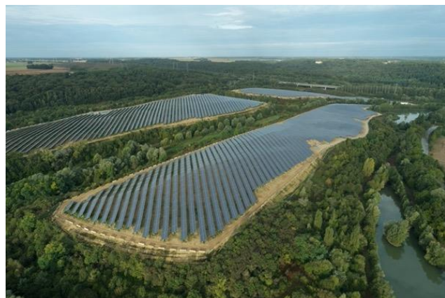
Centrale au sol Marcoussis (91) 23 hectares 20 000 MWh/an
