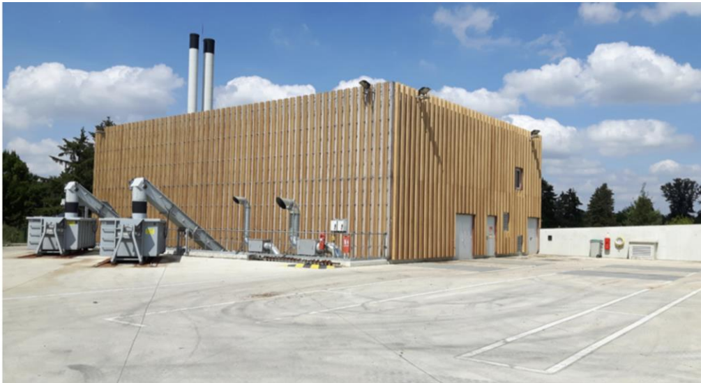
Chaufferie biomasse Saint-Germain-en-Laye (78) Réseau de chauffage urbain 6 MW – 27 000 MWh par an
