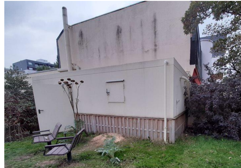
Chaufferie biomasse Courbevoie (92) Ecole maternelle Les Vanettes 110 kW – 80 MWh par an
