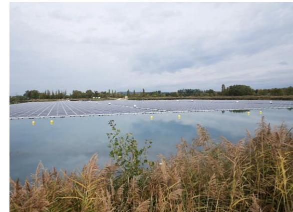
Centrale solaire flottante Piolenc (84) 17 hectares
