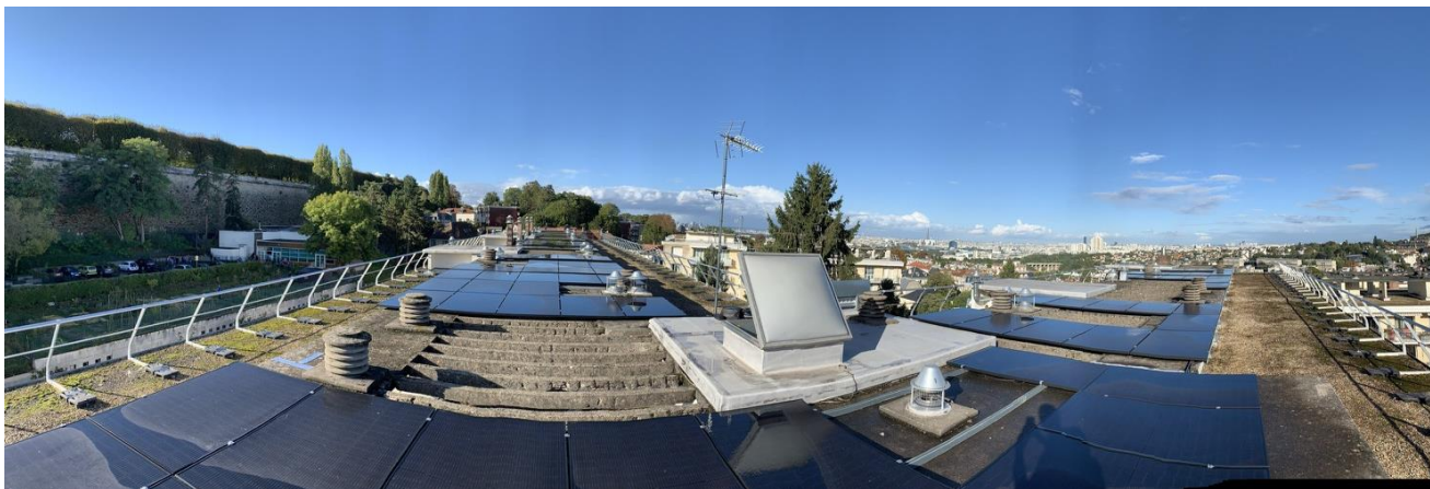
Panneaux en toiture Meudon (92) 650 m2 80 MWh/an
